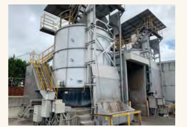
処分場を訪問し処理状況を現地で確認
